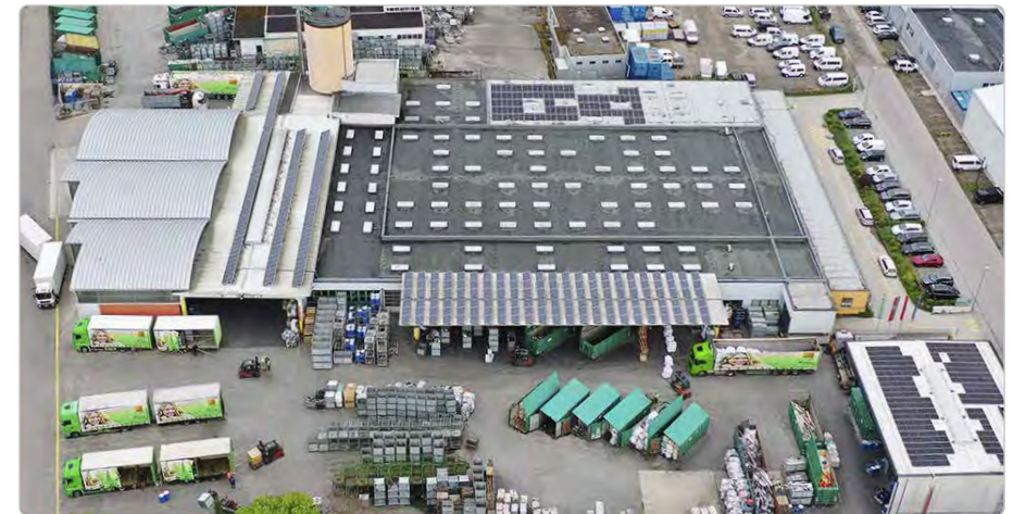
Abfall-Logistikzentrum in Wels
